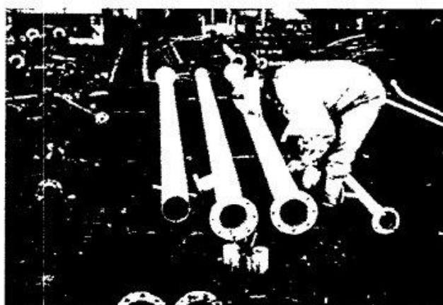
図 2-12： 1 ロットには、通常、異なった複数のパレットの、時としては複数隻に跨るパイプ部品が含まれている。また標準のリードタイムが異なる事から、同じパレットのパイプ部品が複数のロットに跨ることもある。左図：工場内の作業用識別番号を、パレット仕分けに必要な船番、パレット、部品固有番号へと変換するには、多くの図表が必要になる。右図：パレット仕分けに必要なとなる識別番号は、パイプ部品の塗装後に取り付けられる。
